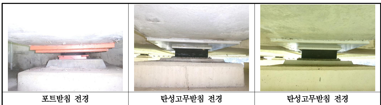
【사진 10.3.37】 교량받침 전경
