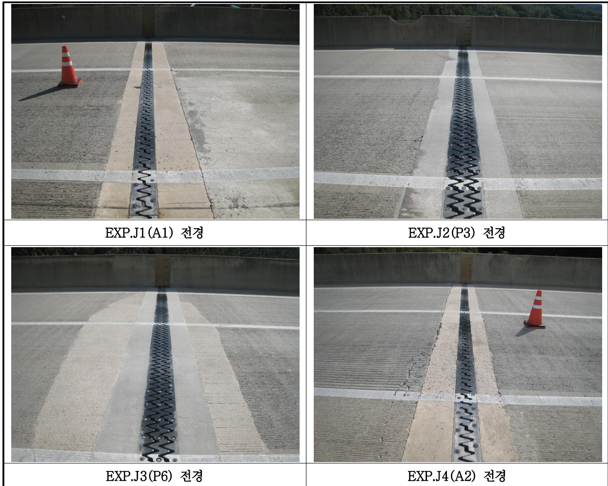
【사진 10.3.16】 신축이음장치 전경
