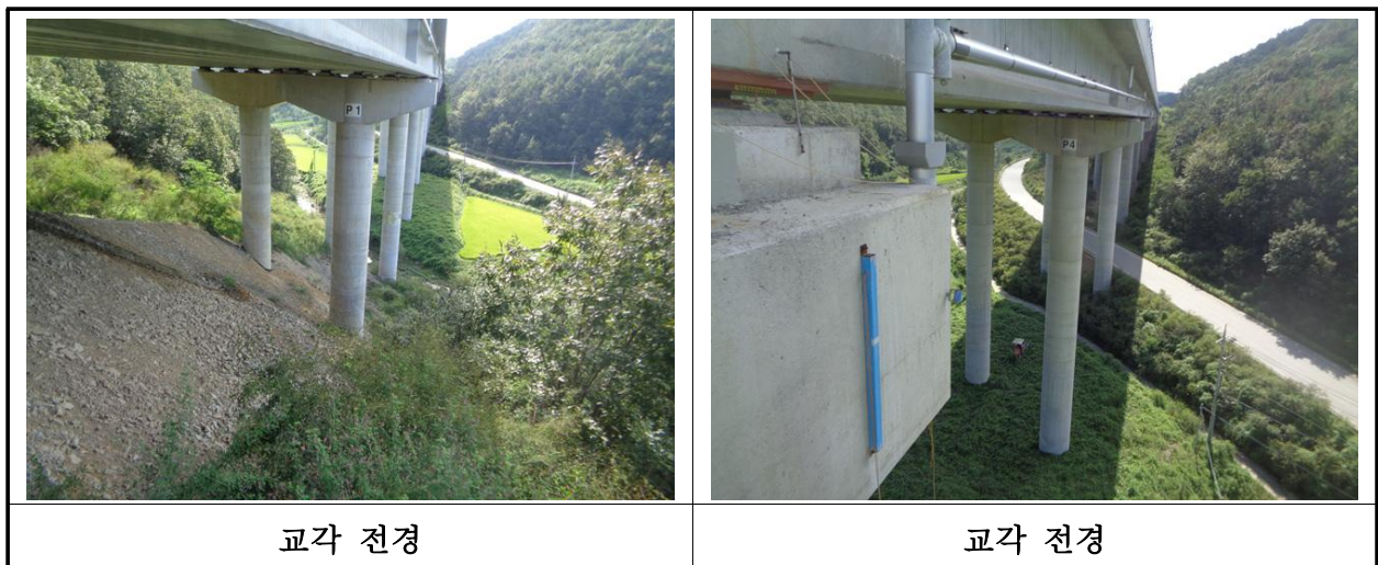
【사진 10.3.35】 교각 전경
