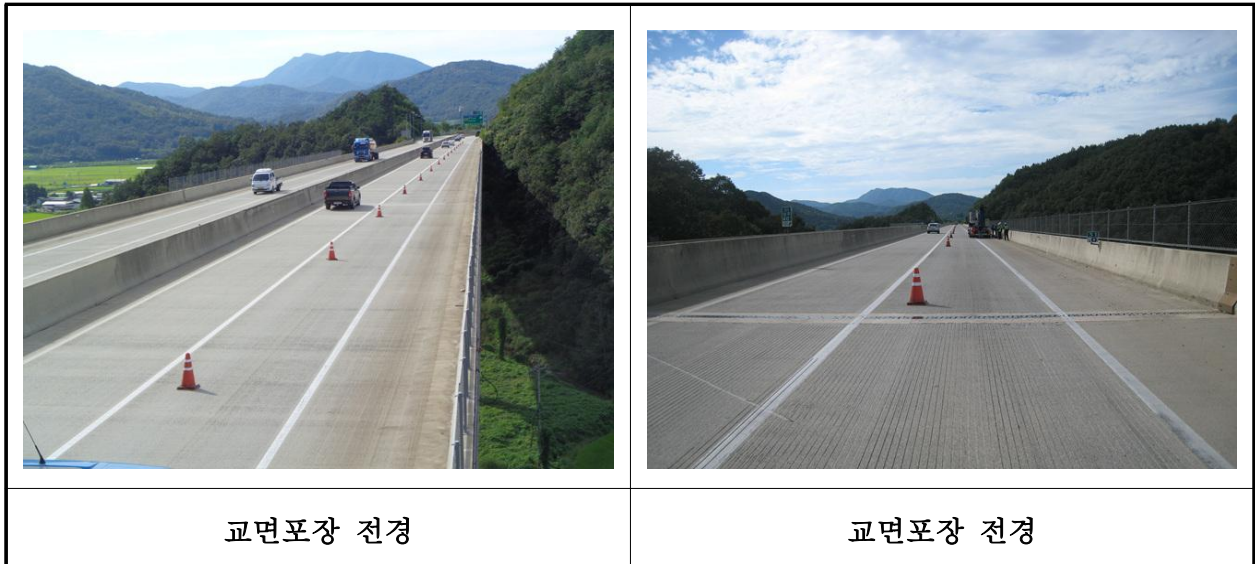
【사진 10.3.19】 교면포장 전경
