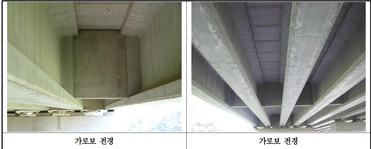
【사진 10.3.31】 가로보 전경
