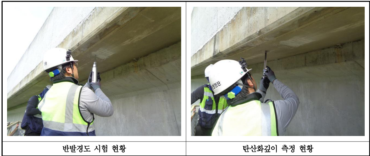
【사진 10.4.1】 콘크리트 내구성조사 현황
