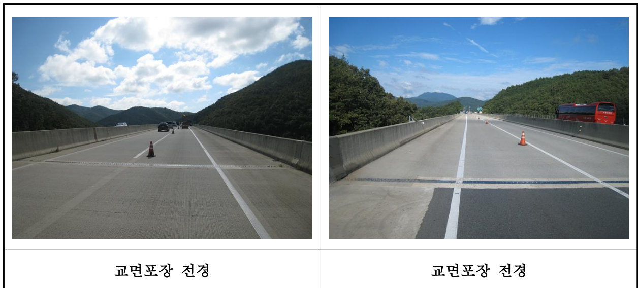
【사진 10.3.44】 교면포장 전경
