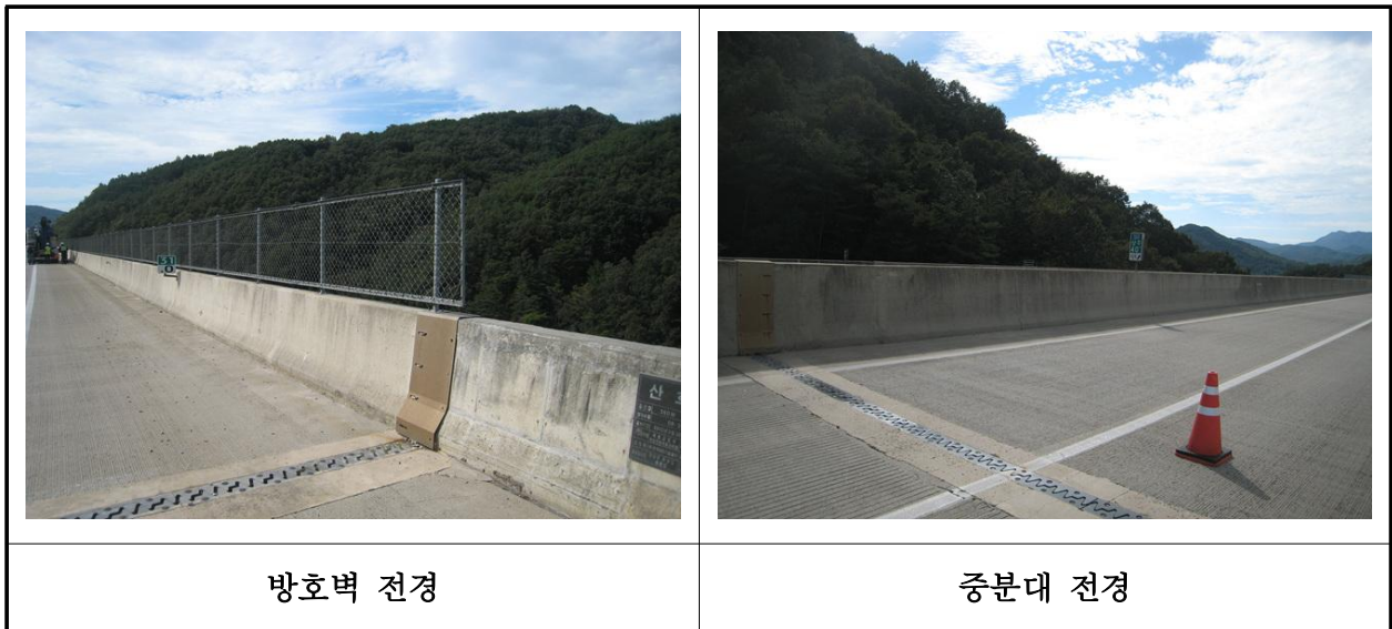
【사진 10.3.23】 방호벽 및 중앙분리대 전경
