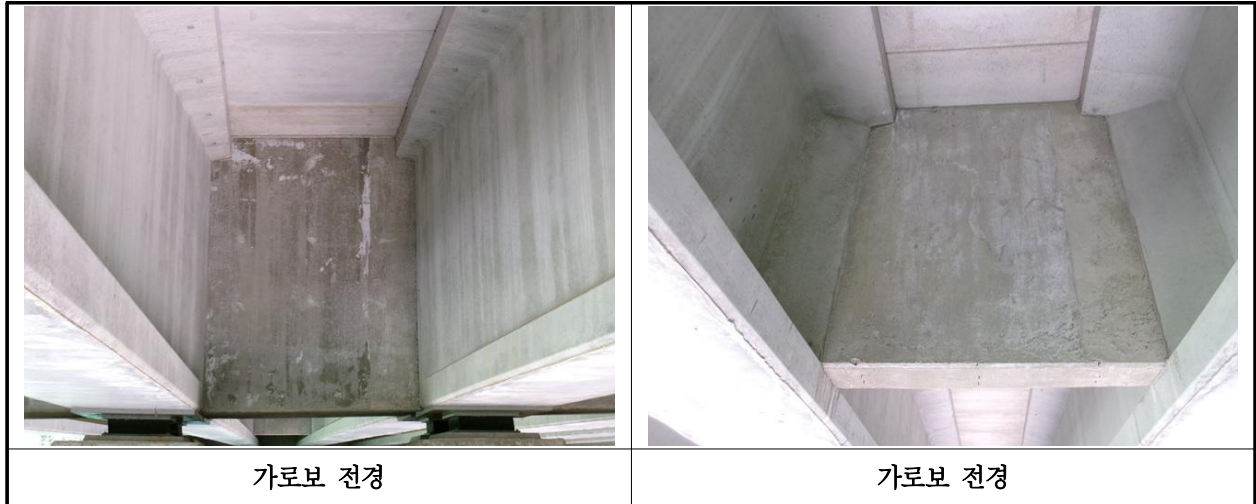
【사진 10.3.6】 가로보 전경
