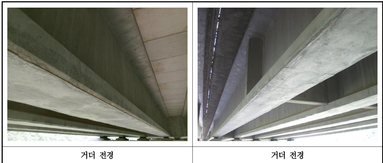
【사진 10.3.4】 거더 전경
