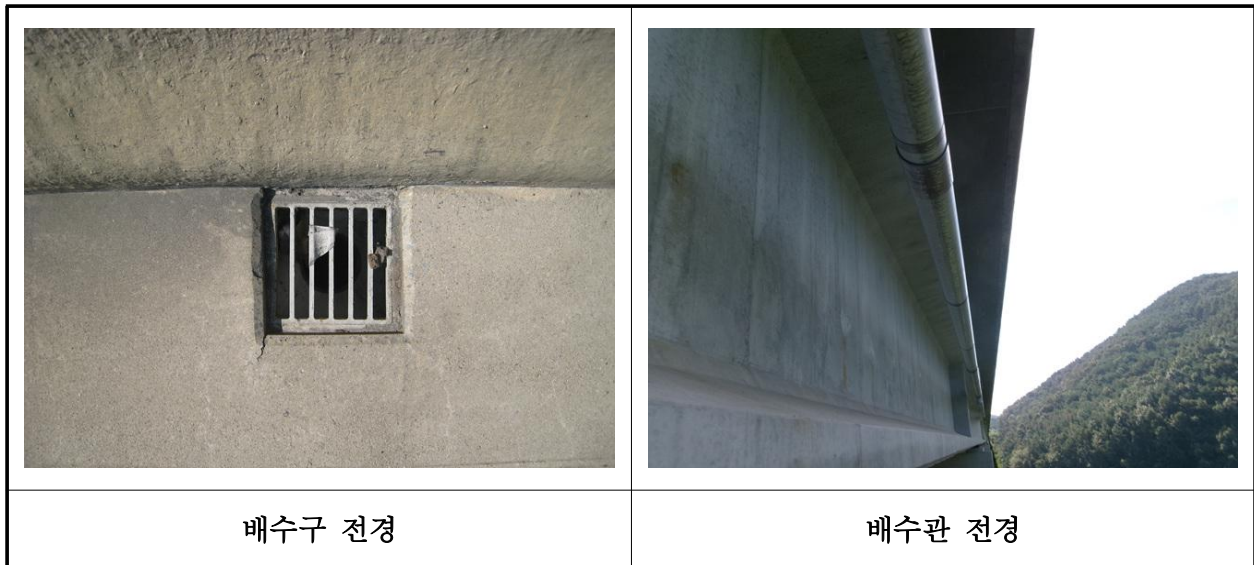
【사진 10.3.46】 배수시설 전경
