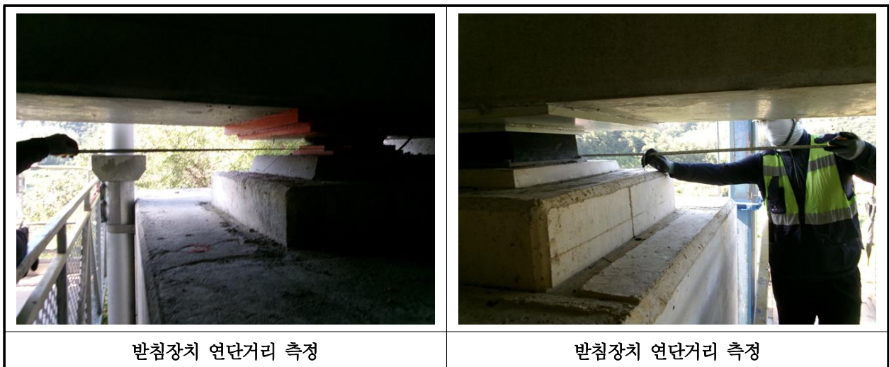
【사진 10.3.39】 교량받침장치 연단거리측정
