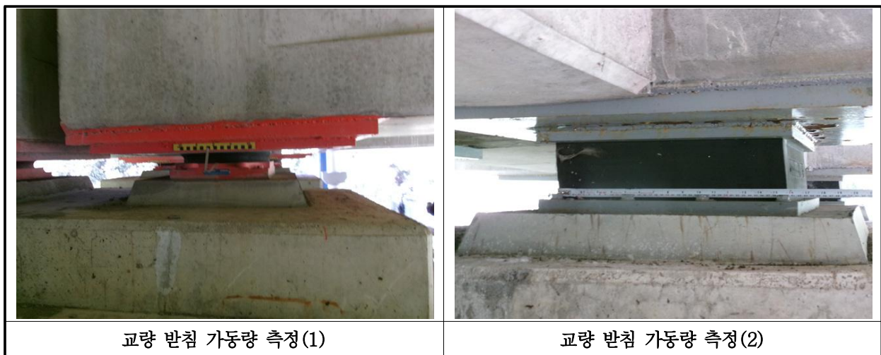
【사진 10.3.15】교량받침 이동량 측정
