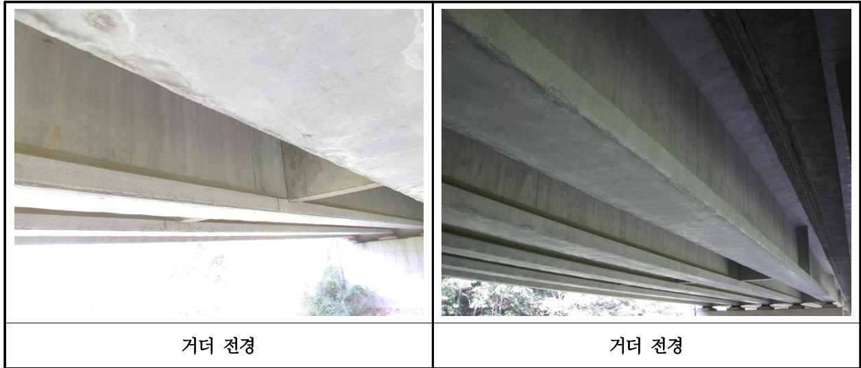
【사진 10.3.29】 거더 전경
