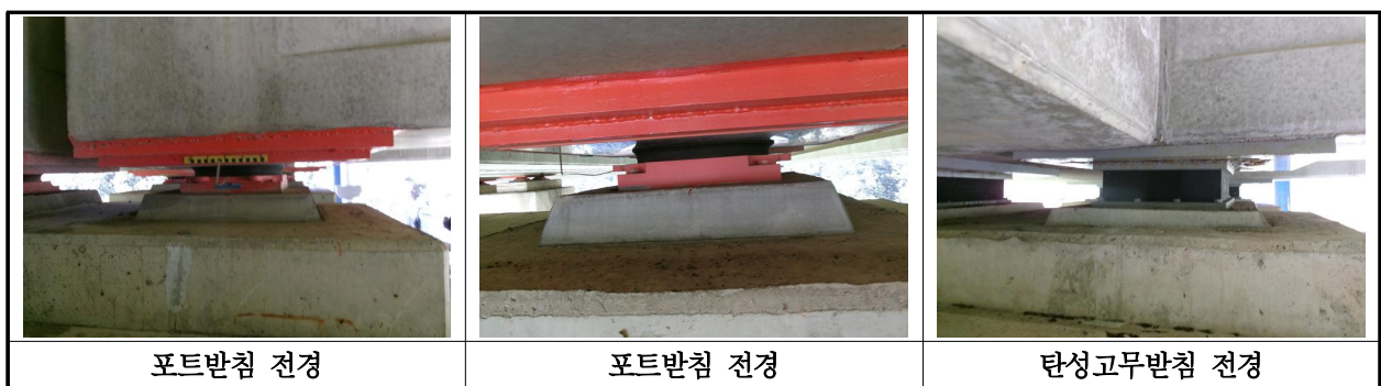
【사진 10.3.12】 교량받침 전경
