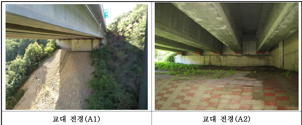
【사진 10.3.8】 교각 전경
