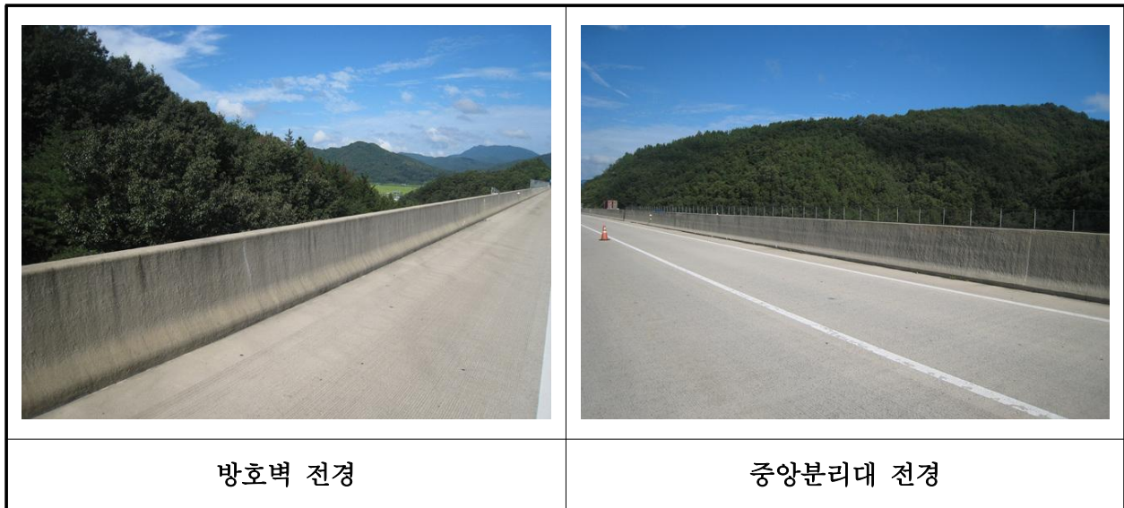
【사진 10.3.48】 방호벽 및 중앙분리대 전경
