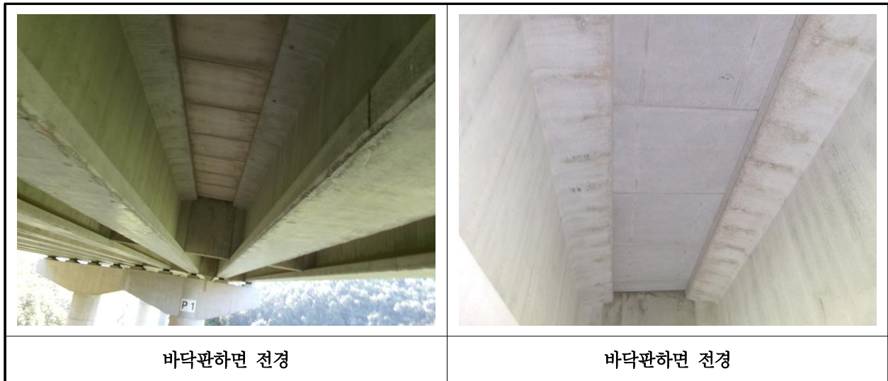
【사진 10.3.27】 바닥판하면 전경
