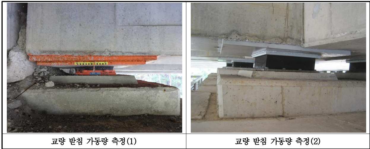
【사진 10.3.40】 교량받침 이동량 측정
