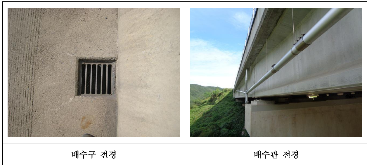
【사진 10.3.21】 배수시설 전경
