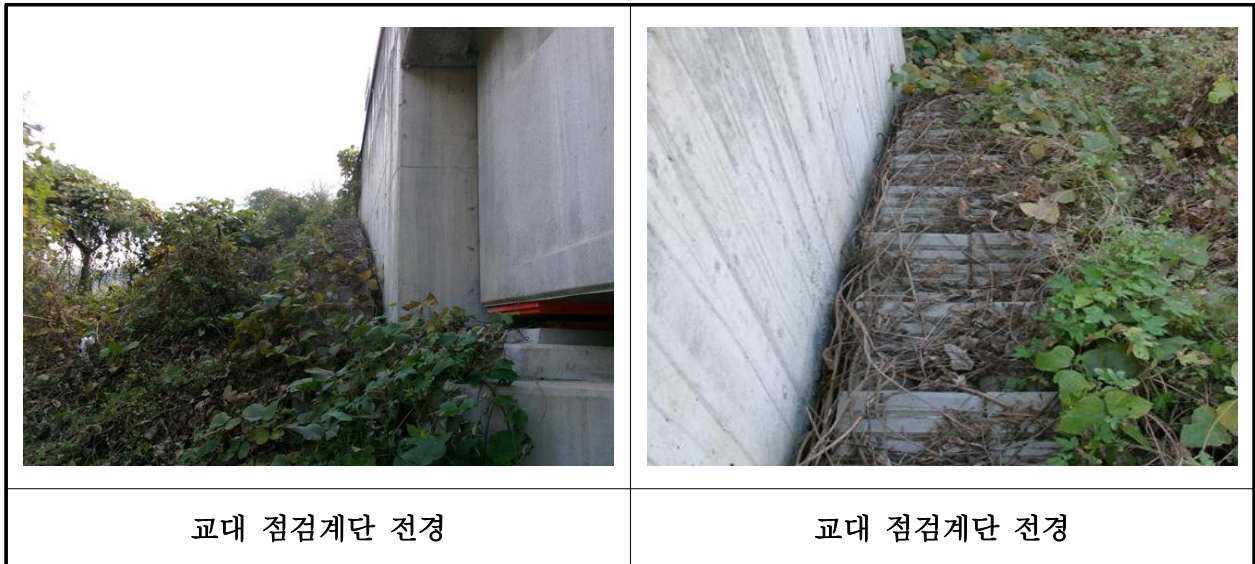
【사진 10.3.25】 교량 점검시설 전경
